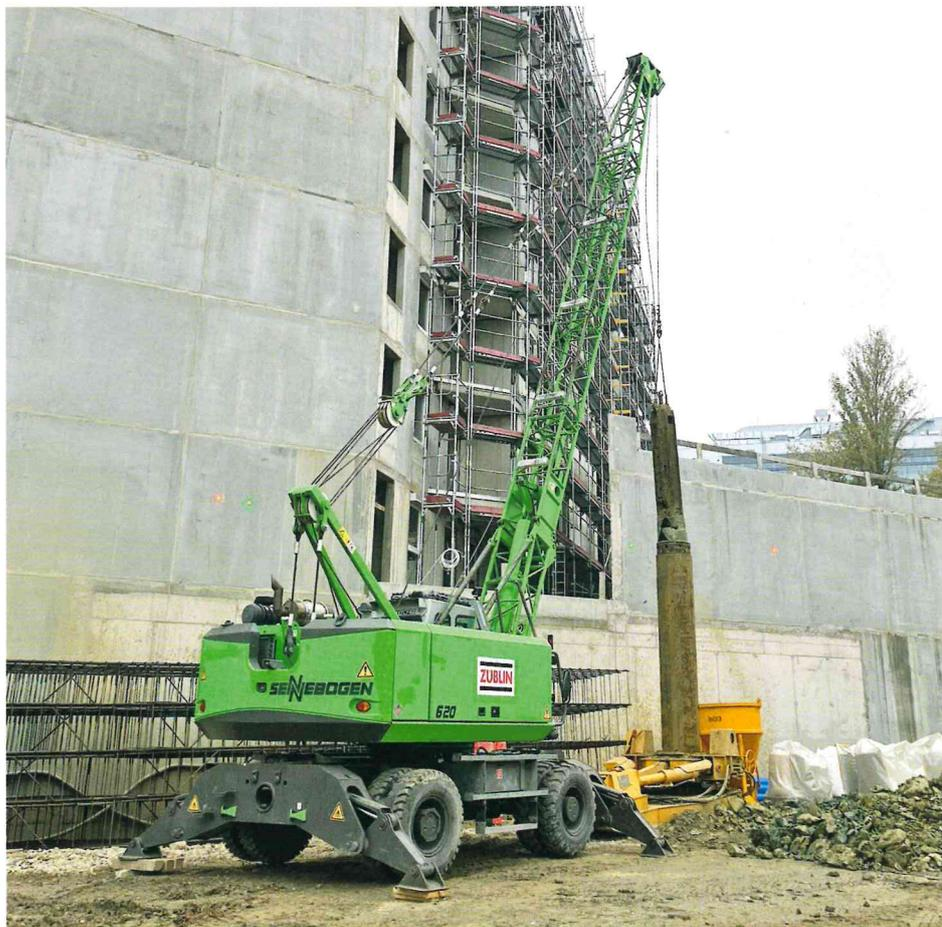
Die insgesamt 16 Brunnen für die Wasserhaltung und die Entspannung des Grundwassers wurden mit einem Sennebogen 620 Seilbagger mit Greiferbohrung hergestellt.
