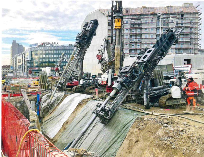
Für die Sicherung der Baugrube wurden 105 BBV multibond-Staffelanker versetzt. Da sie die Ankerlast über mehrere Lasteinleitungsstrecken gestaffelt in den Verpresskörper einleiten, konnte ein zweiter Ankerhorizont vermieden werden.
